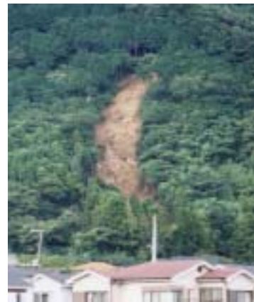
集中豪雨による土崩れ
